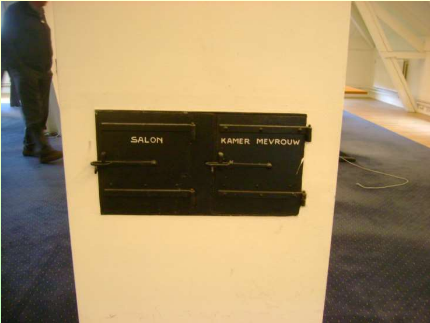
De deurtjes naar de rookkanalen bij de veeggaten met vermelding van de kamers.
