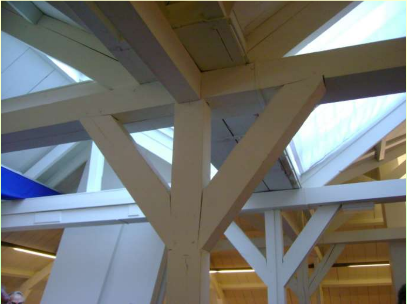
Daglicht door lichtkoepels in het dak.
