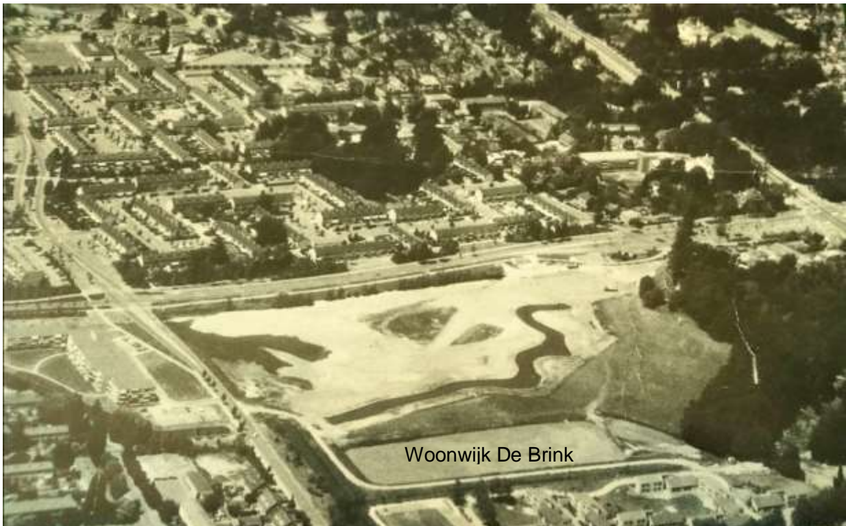
Detail luchtfoto 1978 ter gelegenheid van de opening van 't Holle Bloc' Zeist-West door het Utrechts Nieuwsblad.
