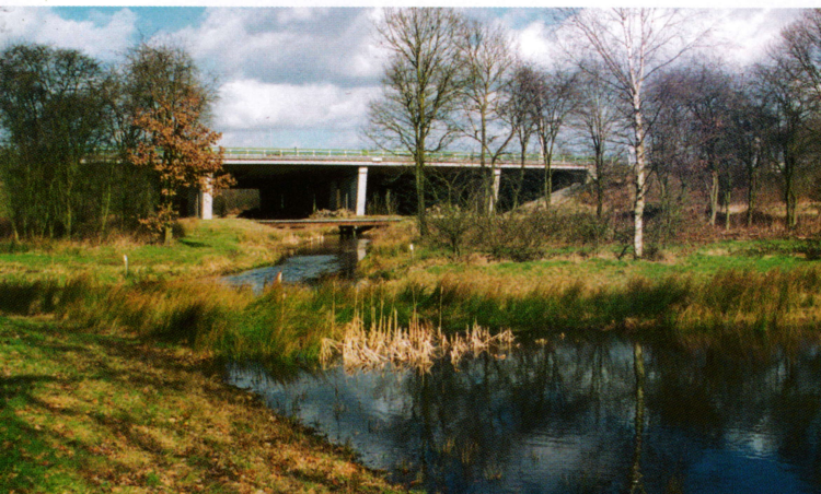
Wildviaduct onder de A28 bij Oostbroek foto - Steffie van den Brink
